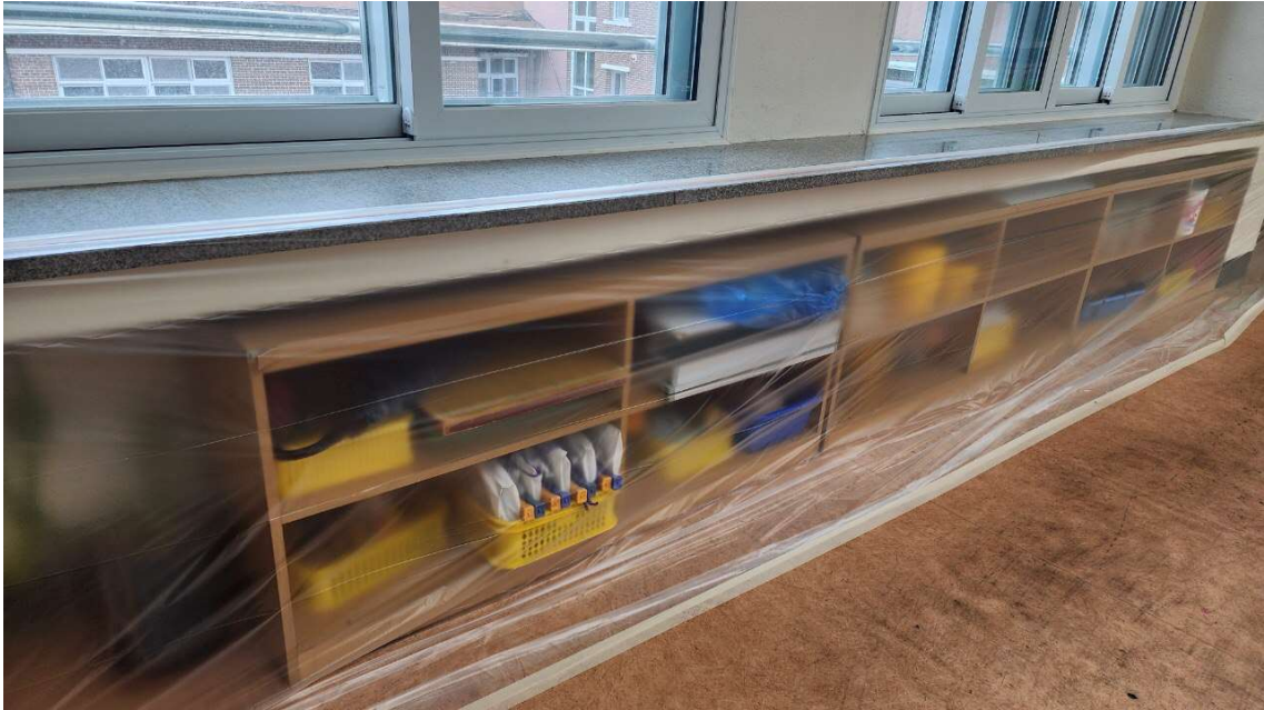
<사진, 2023 년 1 월 목포 한 초등학교, 비닐보양전 검사현장, 집기를 옮기지 않고 비닐로 대충 가려놓았다>
