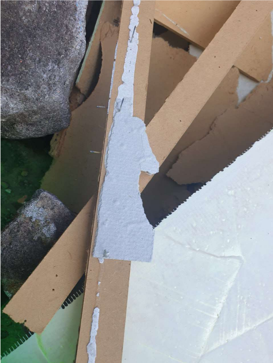
<사진, 2022 년 여름방학 전남 여수 모 초등학교 석면텍스가 제대로 제거되지 않은 채 버려졌다.>
