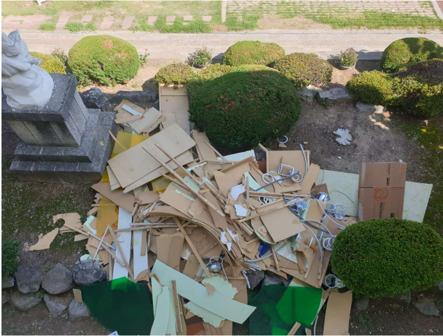
<사진, 2022 년 여름방학 전남 여수 모 초등학교 석면텍스가 여기저기 붙은채 교실 천장 부속품을 떼어 바닥에 던져놓았다.>
