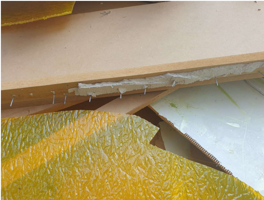
<사진, 2022 년 여름방학 전남 여수 모 초등학교 석면텍스가 제대로 제거되지 않은 채 버려졌다.>
